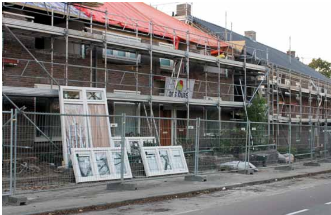
Renovatie aan de Laaressingel.
